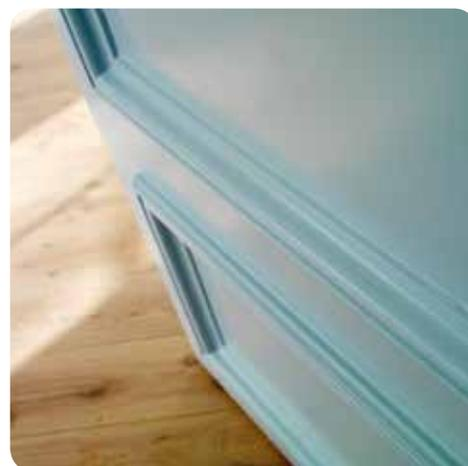
Laque haut de gamme en phase aqueuse mate à pistoler pour l'intérieur à base de résine polyuréthane-acrylique bénéficiant de la technologie LTA<sup>+</sup>. Convient aux projets comprenant beaucoup de travail répétitif.
